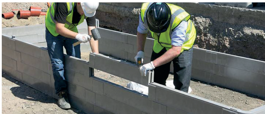
Ultima Connect levereres flatpakket og bygges enkelt i sammen på installasjonsplassen.
