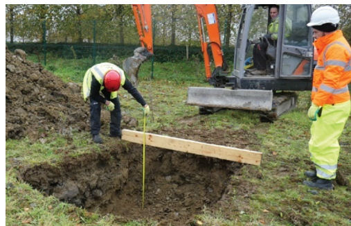
Kontroll av urgrävningdjup
