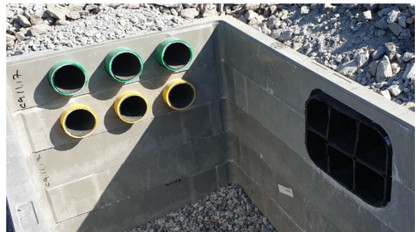
Håltagning i UC sektionssbrunn
