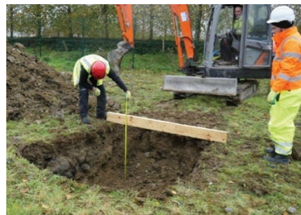
Kontroll av urgrävningsdjup
