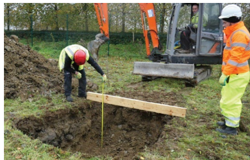
Kontroll av urgrävningsdjup
