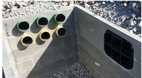
Håltagning i UC sektionssbrunn
